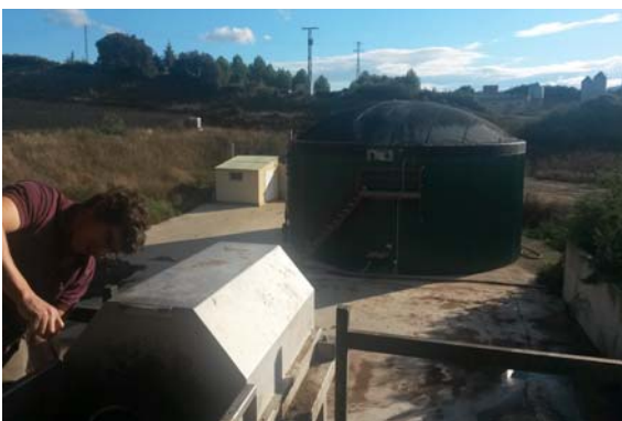
Med benäget tillstånd av: BIOVEC. Småskalig rötningsanläggning i Zaragoza (Spanien)
